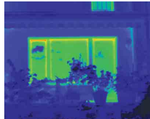
Nach dem sorgfältigen Einbau neuer Schüco Corona CT 70 Cava Fenster beweist die Thermografie den hohen energetischen Nutzen der Investition. Der ursprüngliche Energieverlust wird nahezu vollständig vermieden.
